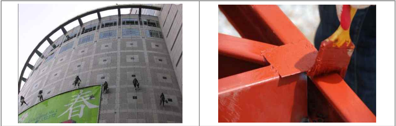
〈사진 2.1〉 도장공사 시공 현황
